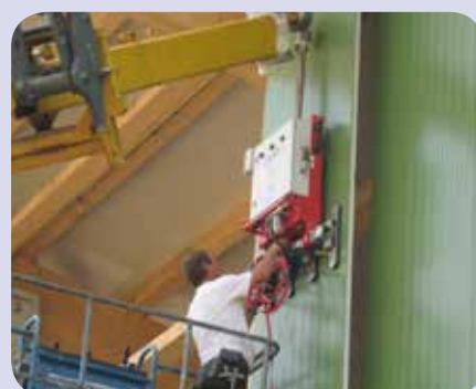
CLAD-BOY® для монтажа стеновых панелей
